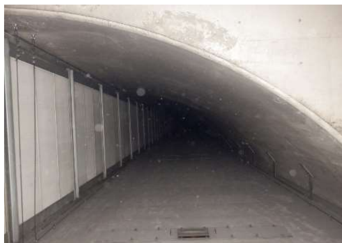
天井板状況写真
