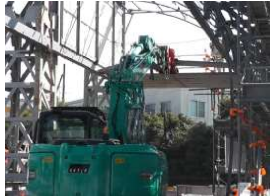
ハンドリングマシンにて試験施工状況
