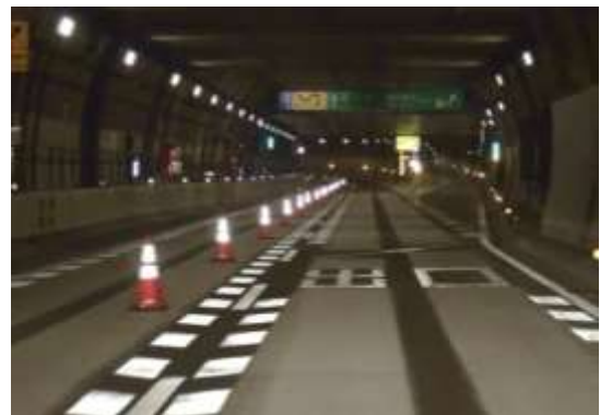
滑り止め対策施工実施後のイメージ
