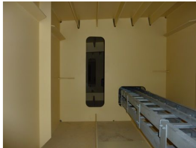
桁内ダイヤフラム開口形状
