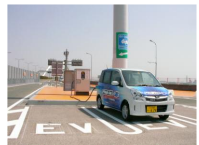
EV用の急速充電器を設置(中島 PA)
