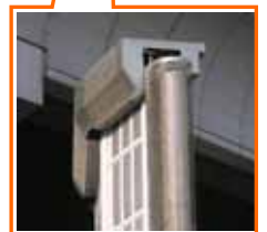
逆位相の音により騒音低減を図る 新型遮音壁の整備 H15年度～
