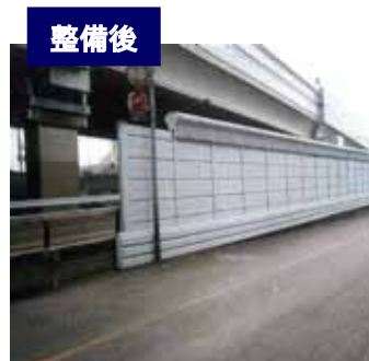
窒素酸化物を吸着する光触媒の塗布 H13年度～
