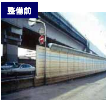
窒素酸化物を吸着する光触媒の塗布 H13年度～
