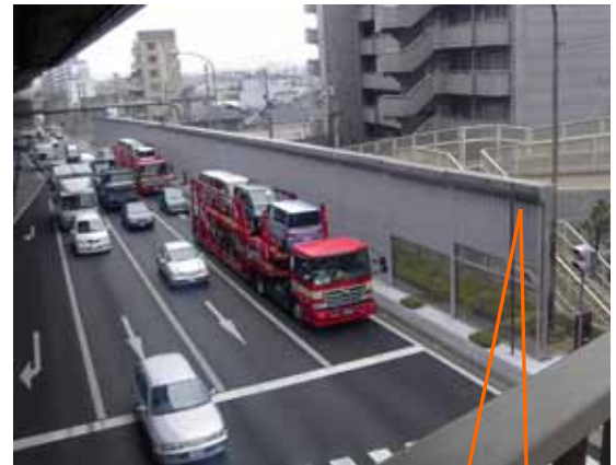
逆位相の音により騒音低減を図る 新型遮音壁の整備 H15年度～
