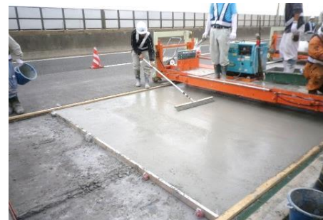
< SFRC 施工状況 >
