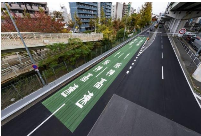
高速入口でのカラー舗装の施工例(堺入口)
