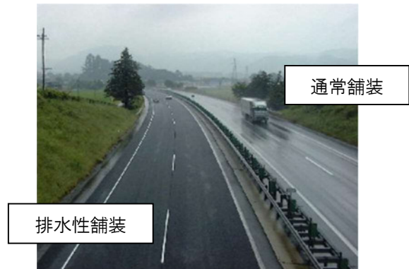
排水性舗装の施工例
