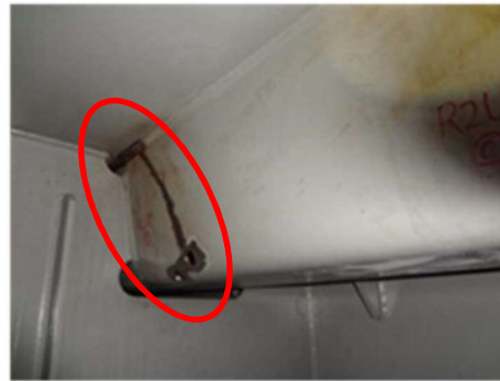
4号湾岸線の鋼床版き裂損傷状況
