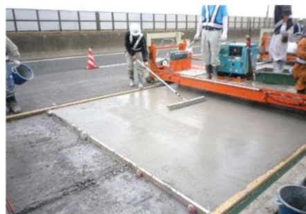
＜SFRC施工状況＞
