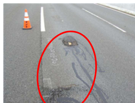
4号湾岸線の鋼床版き裂損傷状況
