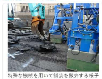
特殊な機械を用いて舗装を撤去する様子
