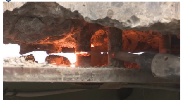
④ スタッドジベルの切断状況(通行止め作業)
