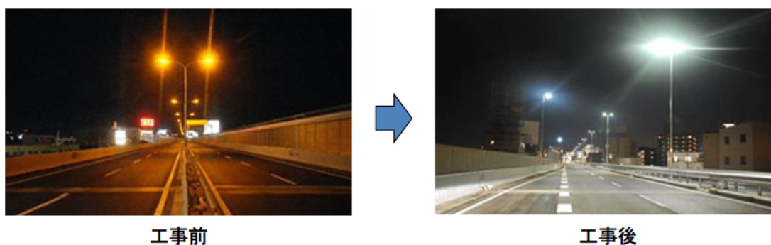
LED 道路照明への取替
