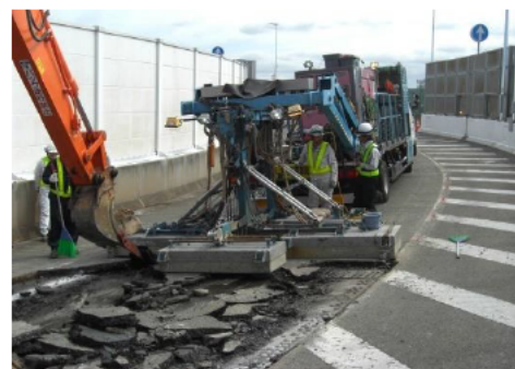
IH ヒーターを使用した舗装撤去工
