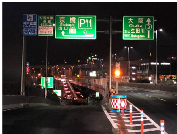
超高輝度反射材料を用いた標識(例)
