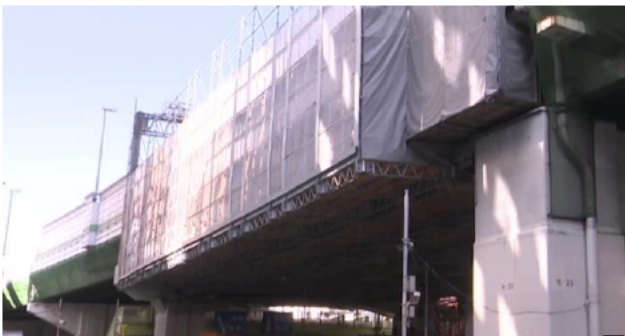
① 防音・防水性の吊り足場設置状況(事前作業)
