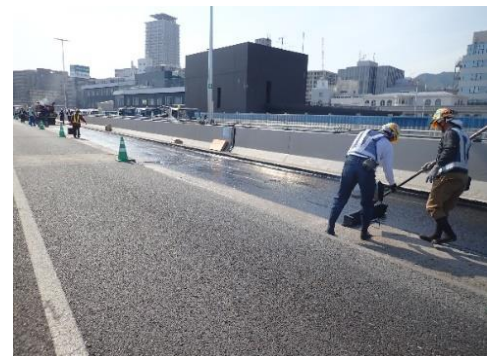
高性能床版防水の施工状況
