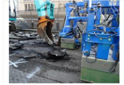
特殊な機械を用いて舗装を撤去する様子
