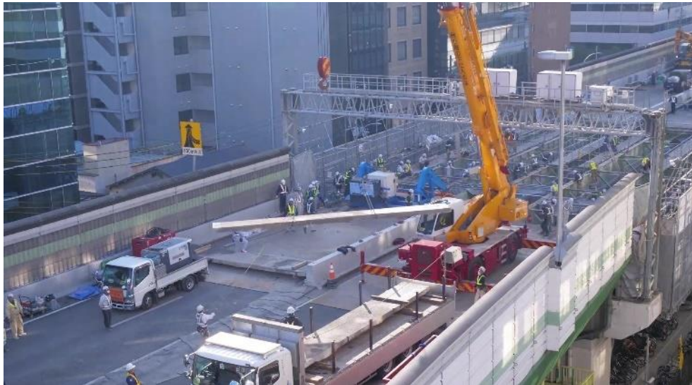
クレーンによるコンクリート床版の撤去状況(2020年守口線)
