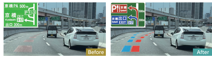
■京橋出口への誘導を促すカラー舗装 ■京橋PAへの誘導を促すカラー舗装
