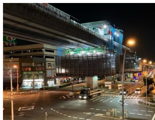
【工程短縮例：防音対策により昼夜間連続作業を実施】
