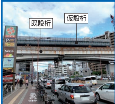
仮設桁の組み立ての様子
