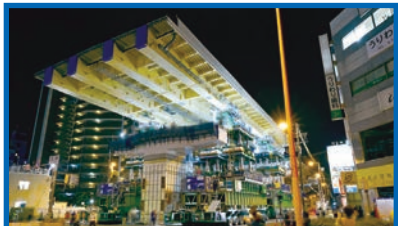
2024年6月1日に実施した南側の新設橋桁架設
