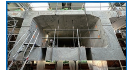
既設橋梁(橋桁)の撤去
