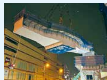
●クレーンによる新設橋脚の架設
