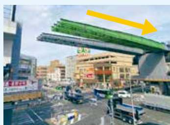
●上下線の仮設桁を一括撤去 （※撤去は夜間に実施）
