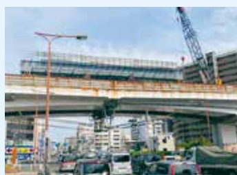
●高速道路上のクレーンによる仮設桁設置
