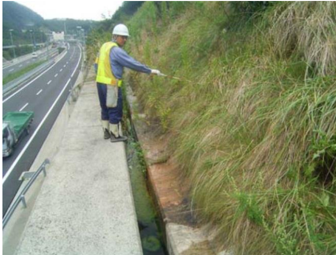
のり面保護工 (植生のり面)
