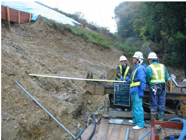
排水対策工 (ボーリング)
