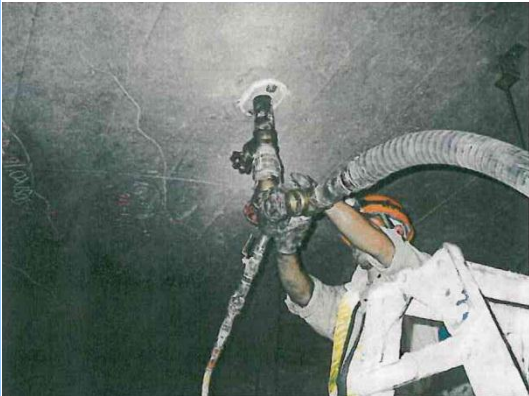
裏込め注入工
