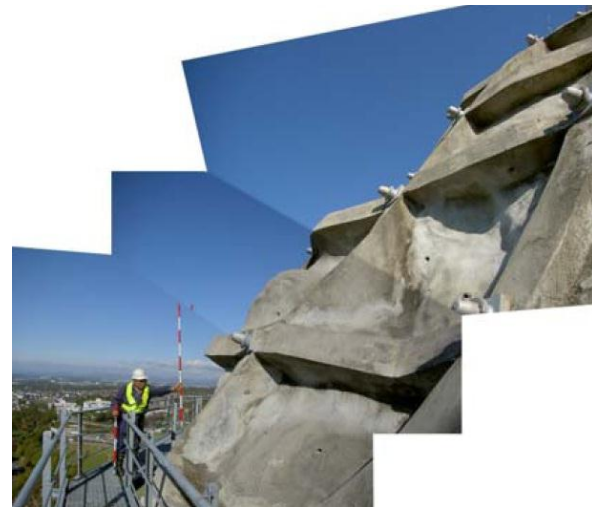
のり面保護工 (のり枠+アンカーのり面)
