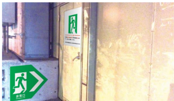
③ 非常口（トンネルからの外観）
