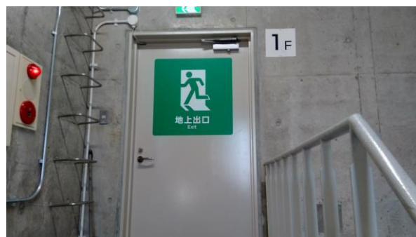
⑥ 地上部扉（階段室内部）
