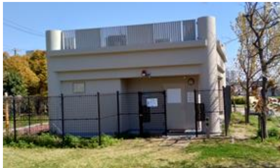
⑧ 地上部非常口（出口外観）
