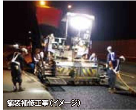
舗装補修工事(イメージ)
