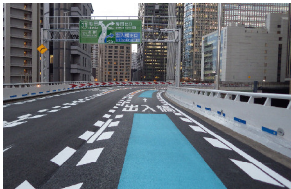
出入橋出口手前のカラー舗装
