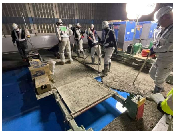
SFRC 舗装の施工状況
