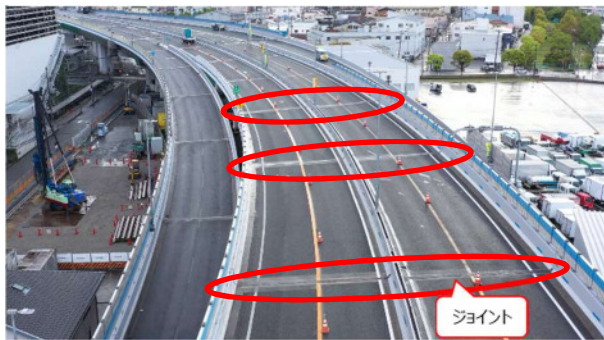
ジョイントレス化(工事前)
