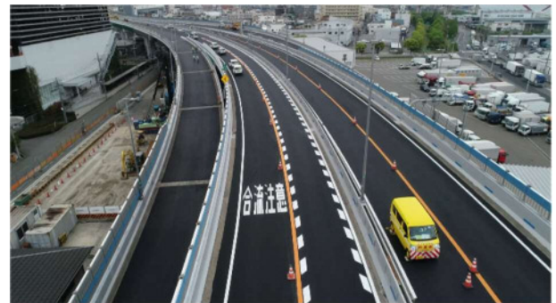
ジョイントレス化(工事後)
