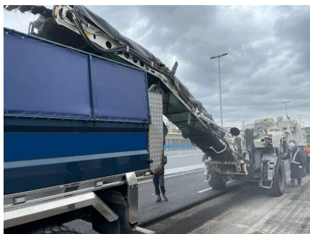
アスファルト舗装の撤去状況
