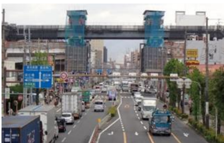
既設橋梁 撤去状況(4 月)
