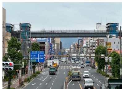
既設橋梁 撤去状況(6 月)
