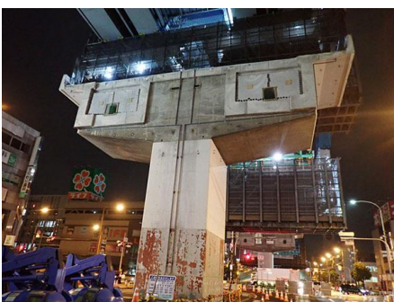
中間橋脚 (上部工撤去後)
