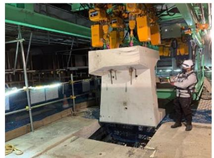
既設コンクリート橋梁の桁切断状況
