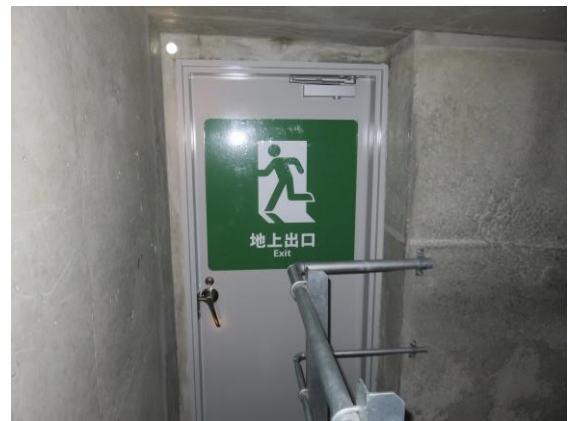
④ 地上部扉（階段室内部より） ※外に出たらオートロックで階段室には戻れません
