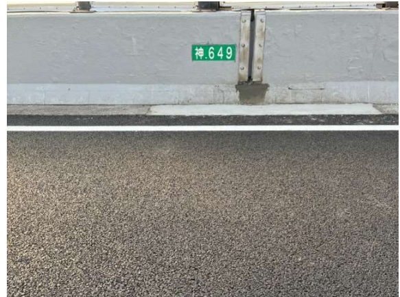
ノージョイント化(工事後)
