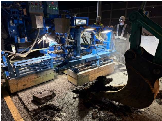
IH ヒーターを用いたアスファルト舗装の撤去状況
