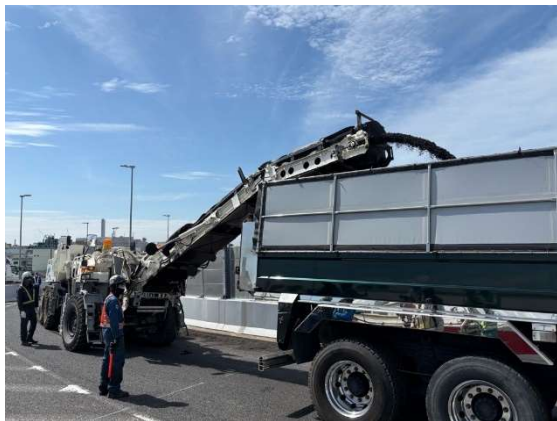
アスファルト舗装の撤去状況
