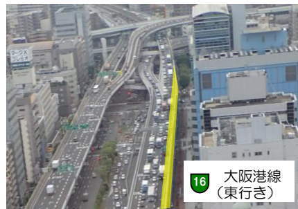
大阪港線拡幅後の状況（阿波座JCT付近）
