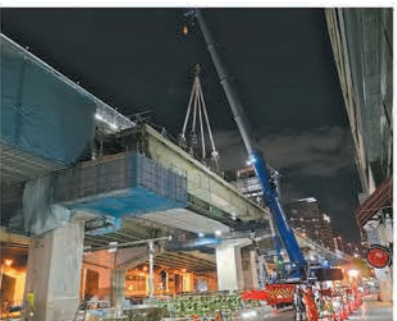
16号大阪湾線 阿波座付近の大規模修繕工事
