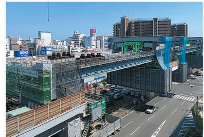
14号松原線 喜連瓜破付近 橋梁の架替え工事
