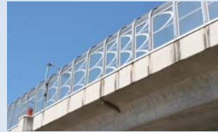
龍の鱗をイメージした側壁（11号池田線延伸部）
