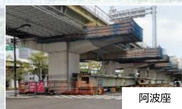
SFRC舗装の施工状況
