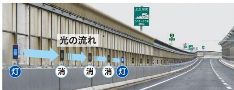
3号神戸線(東行き)深江サグ付近
