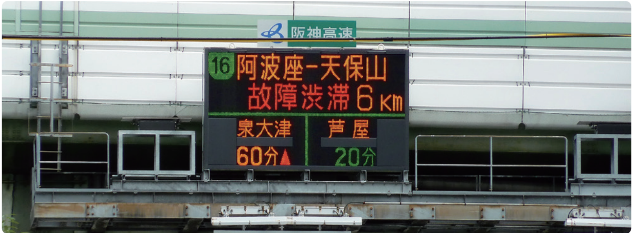
入口付近に設置した表示板（傾向表示が点灯して所要時間が増加中）
