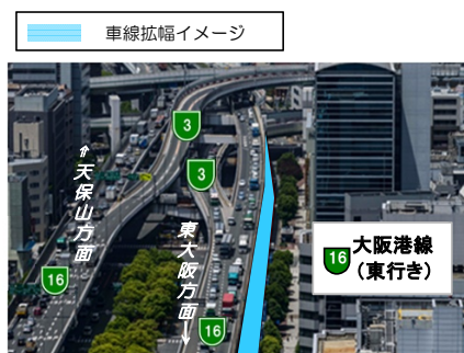
【イメージ】 車線拡幅(大阪港線(東行き))
