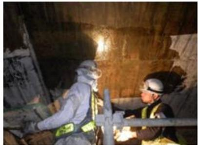
5年ごとの詳細点検および日常の道路巡視，年2回の目視による定期点検を実施し，早期把握・こまめな補修を実施することで，長期にわたり十分な耐久性を確保できると考える。また，非破壊検査手法の活用などにより，内部の損傷状態を高い精度で把握することができる。
