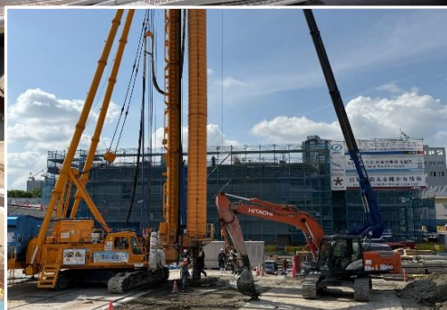
②トンネル部 地盤改良工
