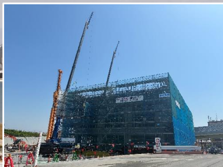
④受電所 地上躯体工
