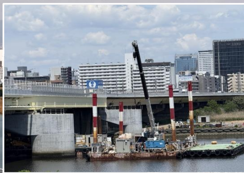
③河川内 隔壁工
