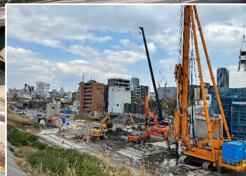
②トンネル部 地盤改良工
