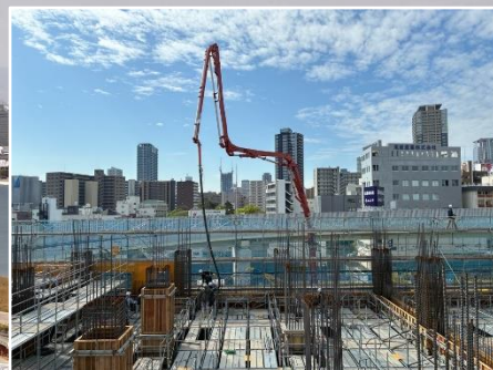
④受電所 地上躯体工
