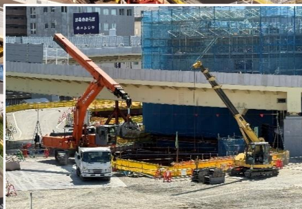
⑤換気ダクト部 掘削工
