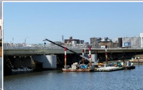
③河川内 隔壁工
