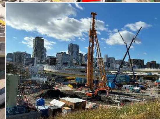
②トンネル部 地盤改良工
