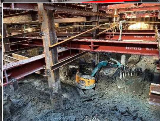
①換気所 掘削工
