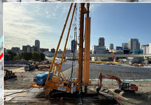
②トンネル部 地盤改良工
