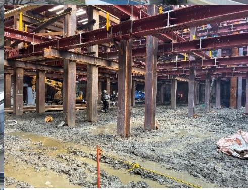
①換気所 掘削工
