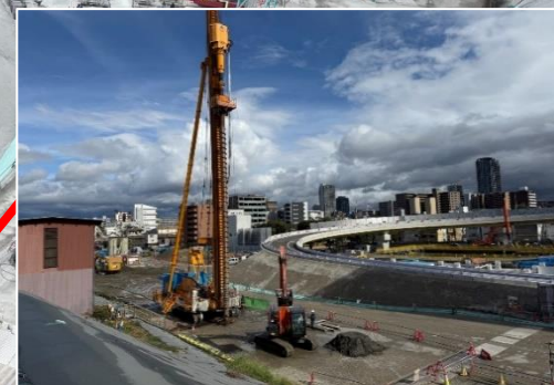
②トンネル部 地盤改良工
