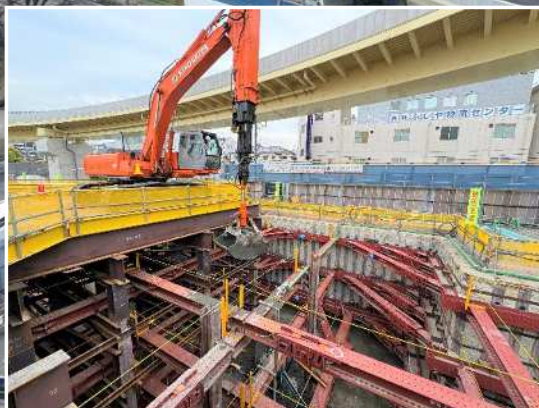
①換気所 掘削工
