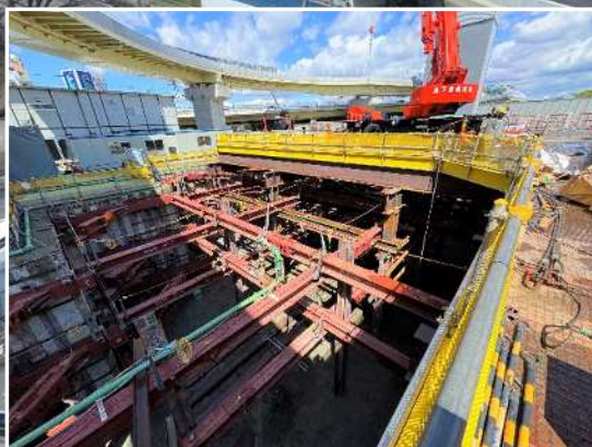
①換気所 掘削工
