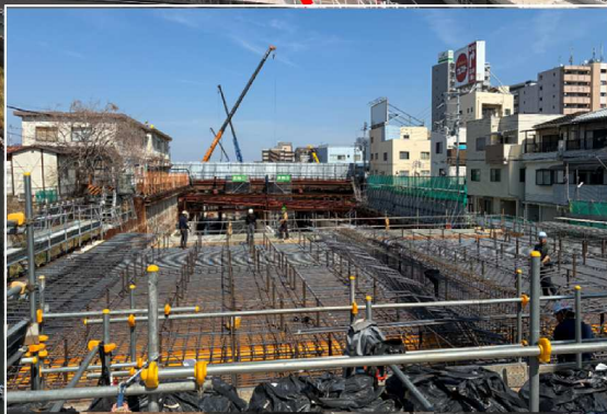
② 頂版コンクリートの鉄筋組立
