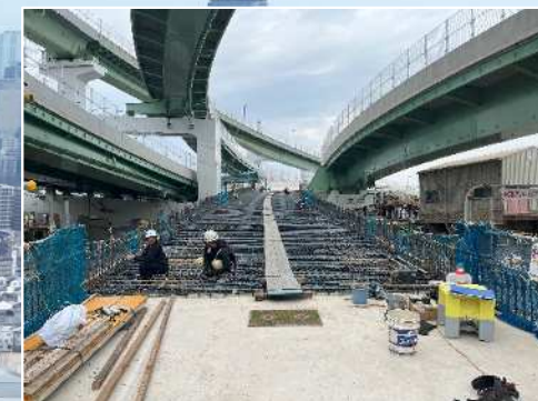
①床版の打設準備
