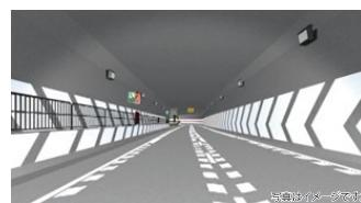
島屋のカーブ手前の直線区間に壁面に、速度抑制効果を期待したトンネルデザインを施しました。トンネル内に施した一連の模様の間隔を調整することにより、心理的に運転者に速度抑制を促します。
