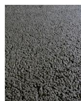
トンネル内に流入した雨水によるスリップ防止として、トンネル入口から最初のカーブ区間に排水・透水性に優れたポーラスコンクリート舗装を施しました。大型車の通行が多い重交通路線で、1万tを超える大規模施工は日本初です。
