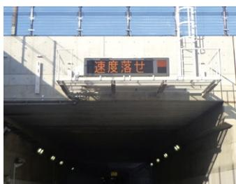
トンネル入口手前で、走行車の速度を計測し、「速度落せ」などの注意喚起をトンネル・坑口警報板で行います。
