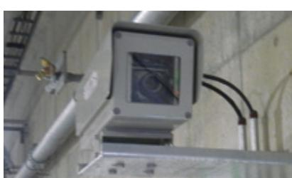
170台のカメラによる映像は管制室内のモニターに映し出され、トンネル内の状況を把握することができます。またこの映像を画像処理し、車両の停止、低速、渋滞、障害物等を避ける動きなど異常な走行状態を自動的に認識する装置を設置しています。
