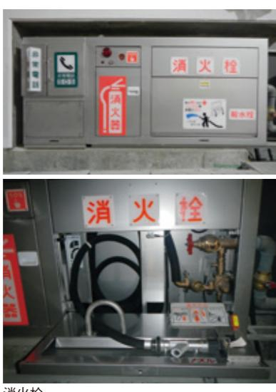
消火栓はホースの長さが約30mの放水器具です。油類の消火には使用しないでください。
