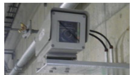
170台のカメラによる映像は管制室内のモニターに映し出され、トンネル内の状況を把握することができます。またこの映像を画像処理し、車両の停止、低速、渋滞、障害物等を避ける動きなど異常な走行状態を自動的に認識する装置を設置しています。
