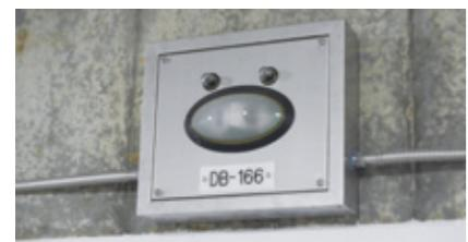
赤外線センサーで炎を検知し、火災が発生したと判定した場合、自動的に管制室へ通報されます。
