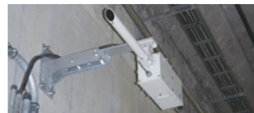
排気ガス、塵埃、霧による視界の低下を測定します。
