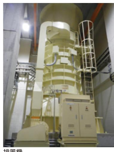
火災発生時には避難環境を確保するため、煙の流れをコントロールし、普段は排気ガスによるトンネル内の環境悪化を防止します。
