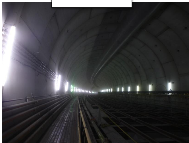
①東行トンネル
