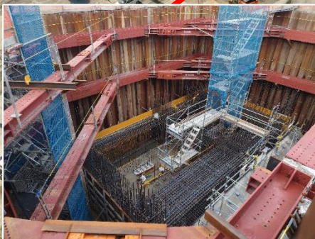
②換気塔部の躯体工
