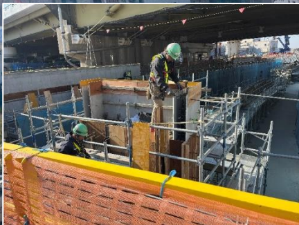
③擁壁部の側壁・高欄 コンクリート打設
