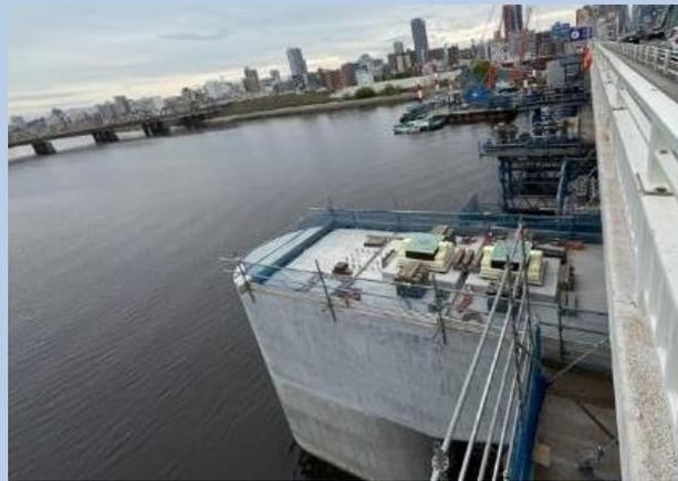
①上部工架設用のベントの設置工
