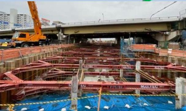
③擁壁部の掘削・土留支保工
