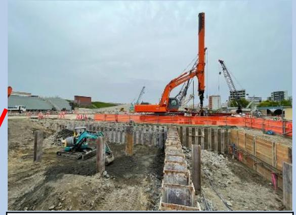
②換気塔部の掘削・土留支保工
