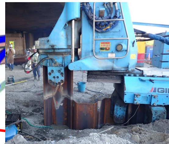
④鋼矢板の打設
