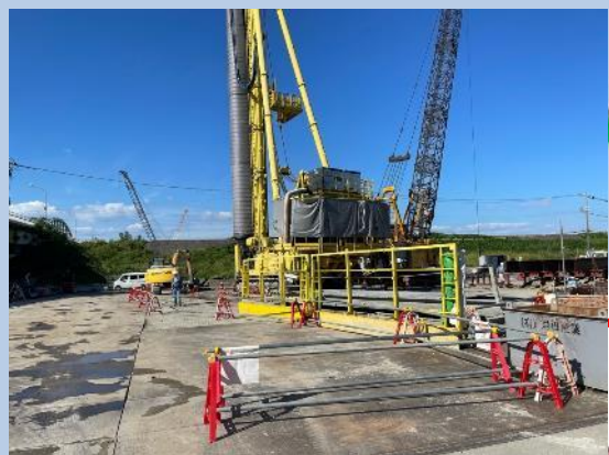
③土留工 (地中連続壁工)
