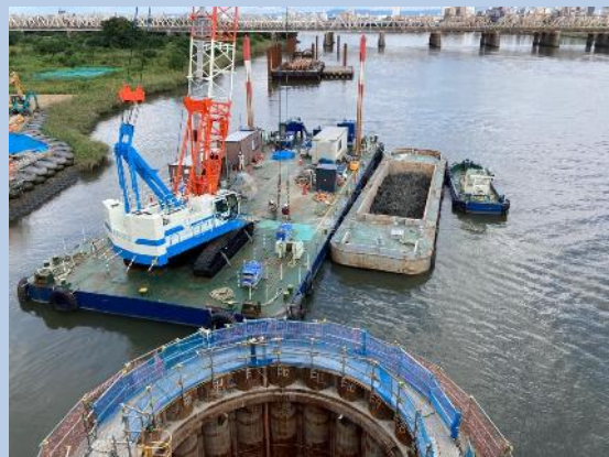
①河川内の 鋼管矢板井筒基礎内の掘削
