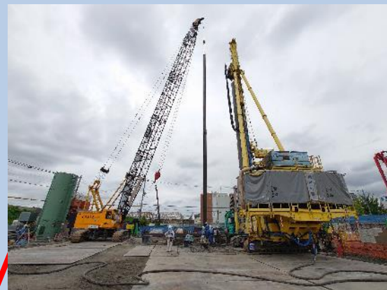
②中間杭の施工
