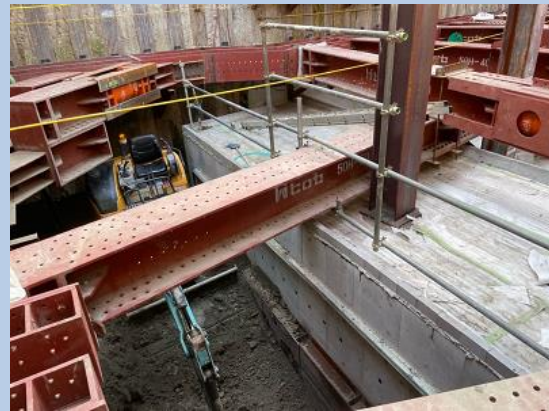
③躯体の埋戻施工
