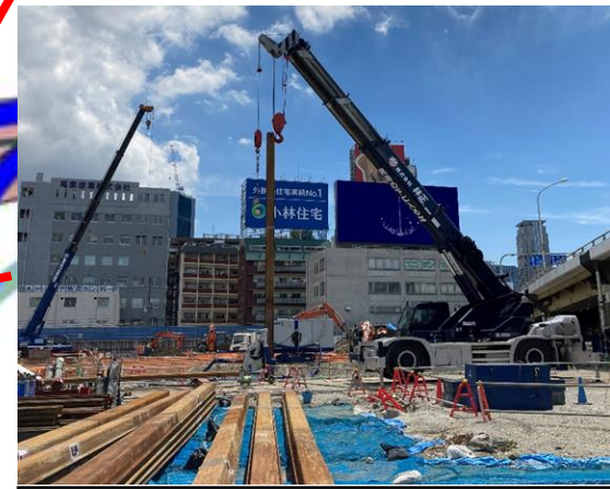
④鋼矢板の打設
