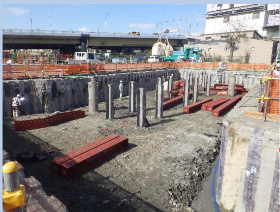
掘削施工①
