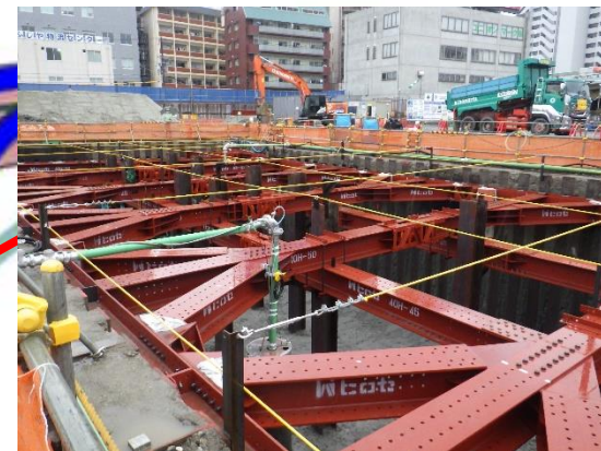
掘削施工②
