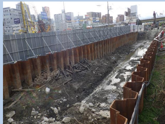
支障害物撤去
