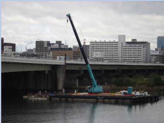
河川内の磁気探査
