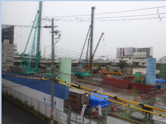
橋脚 杭基礎の施工
