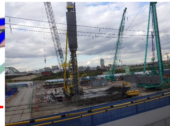
地中連続壁 (土留め) 施工
