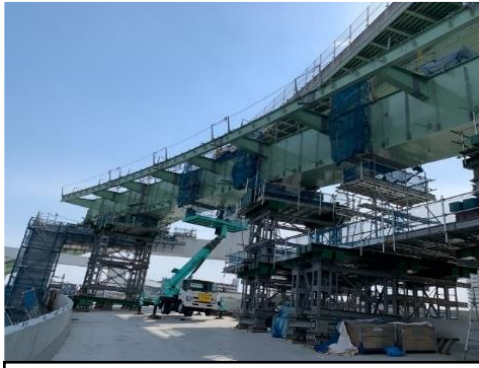
①橋桁の設置
