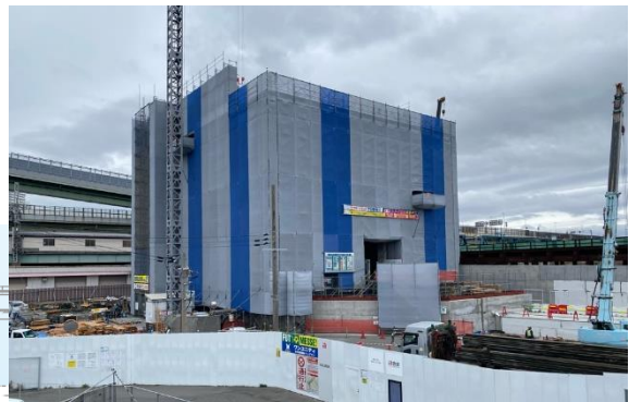
③換気所3~4階部の構築
