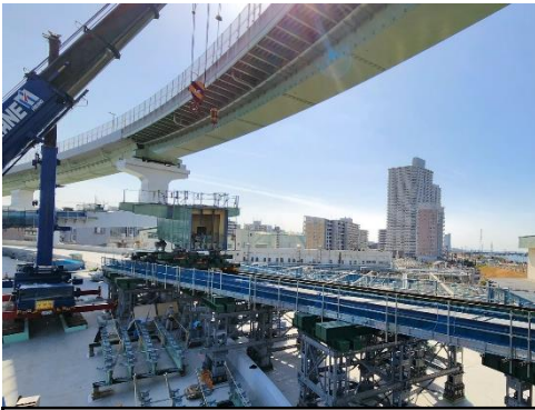
①橋桁の設置
