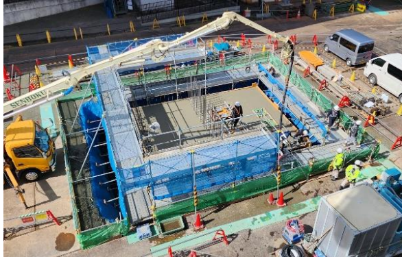
②橋台の底版コンクリート打設
