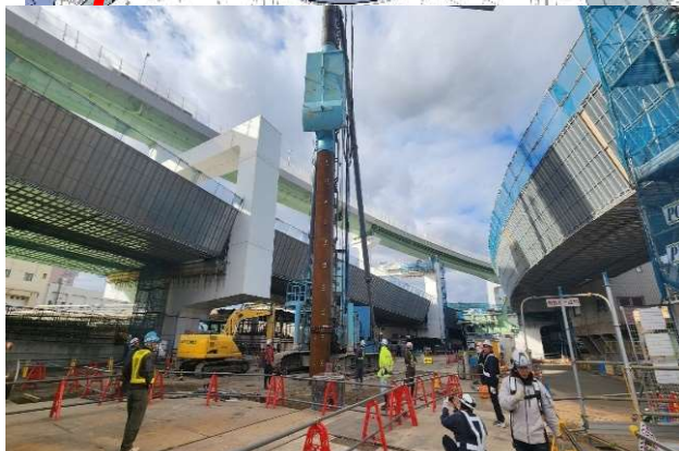
②橋台構築のための杭打設
