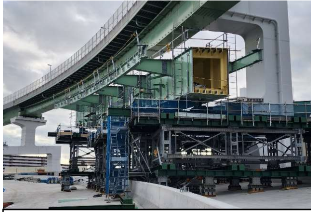
①橋桁の設置
