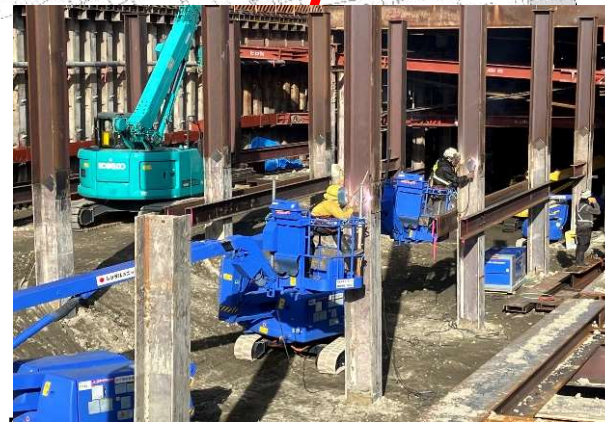
④栈橋のための杭を設置
